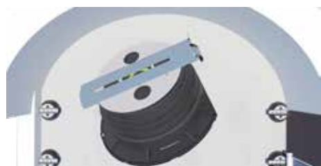
7. Umístěte SUPACLPP kolmo ke stěně.
