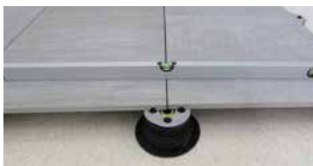
16. Zkontrolujte, zda je podlaha vyrovnaná.
