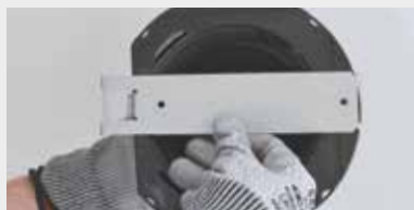
D1. Umístěte klip SUPACLPB pod základnu terče.
