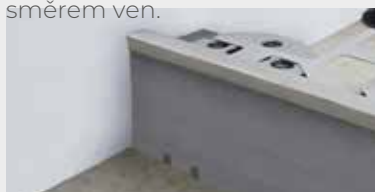
D5. Vklíněte uříznutou dlaždici mezi profil BSJ a klip SUPACLPB.
