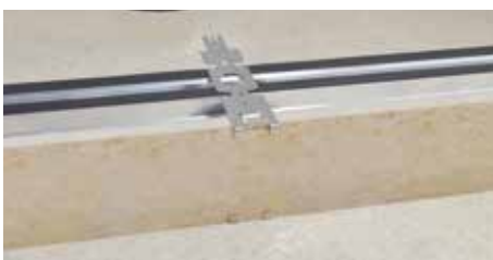
14. Vzpříčte nařezanou dlaždicí mezi klip SUPACLPT a klip SUPACLPB.
