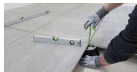
17. Pokud podlaha není vyrovnaná, upravte výšku pomocí nástroje SUPAK.
