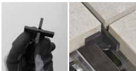
16. Vložte distanční podložky SUPDG do drážky na nosnících tak, aby byla zachována stejná vzdálenost mezi dlaždicemi.
