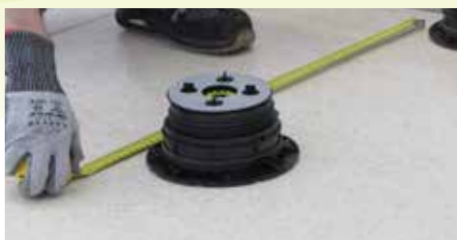
12. Umístěte střed terčů do stejné vzdálenosti, jako je rozměr dlaždice. Rozteč by neměla přesáhnout 60 cm na střed.
