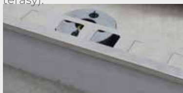
E5. Vklíněte uříznutou dlaždici mezi profil BSJ (nahore) a klip SUPACLPB (dole).
