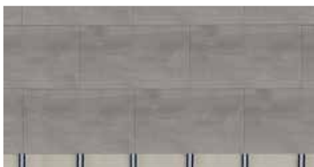
17. Nainstalujte zbytek dlažby.
